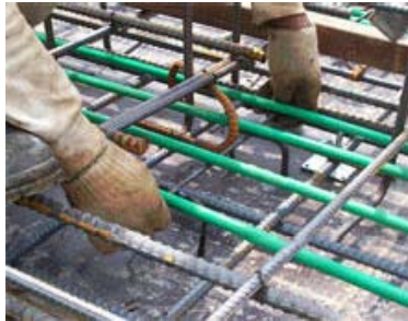
Gambar-10 : Instalasi monostrand Gambar-11 : Instalasi Angkur hidup
