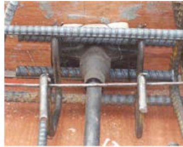
Gambar-10 : Instalasi monostrand Gambar-11 : Instalasi Angkur hidup
